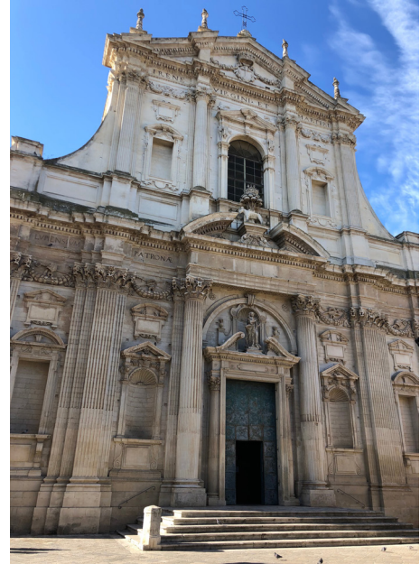
Fig. 2. Chiesa di Sant'Irene, facciata, Lecce.
