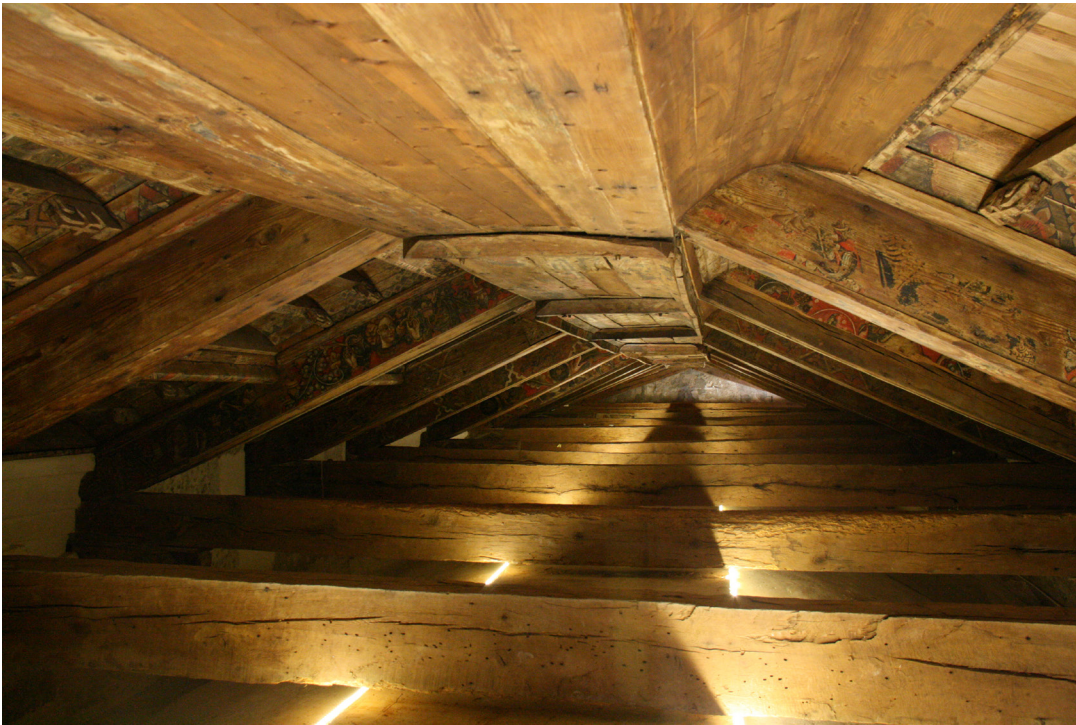
Fig. 1. Soffitto ligneo della Cattedrale di Nicosia, metà del sec. XV, la fuga delle capriate, veduta generale (per gentile concessione della Diocesi di Nicosia).
