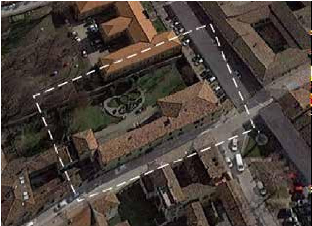
Fig. 1. Veduta aerea di Palazzo Zurla nel contesto urbanistico attuale.
